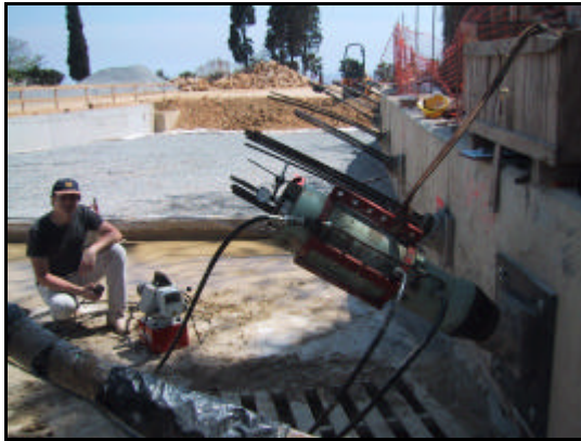
Realización de un ensayo de carga
