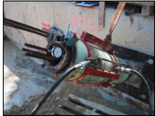
Instrumentación del gato de tesado
