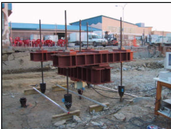
Ensayo de carga a compresión
